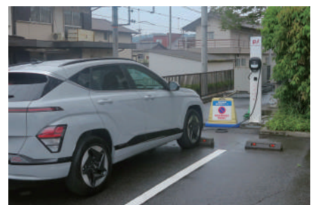
ルートインホテルズでは宿泊客以外の利用を制限するため補助金を使わずに充電器を設置
