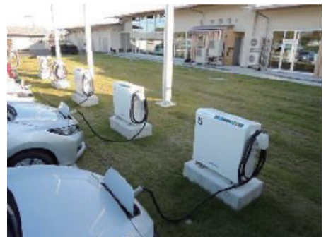
福島県浪江町復興スマートコミュニティ計画(道の駅なみえ) 2022年 EV+充放電器導入で自治体の非常時対策
